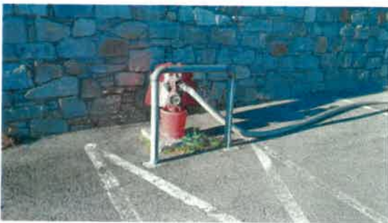
Branchement du poteau 08/2022
